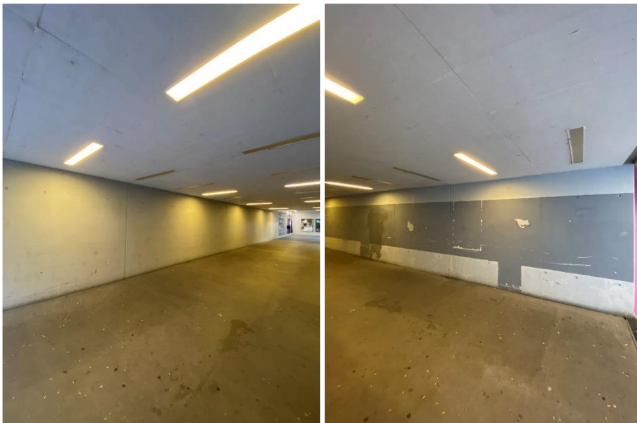
Abbildung 1: Eindrücke der Hauptunterführung zwischen Bahnhofsgebäude und Altstadt.
